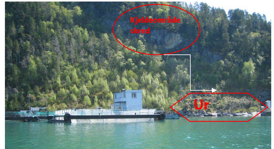
Bilde viser kjeldeområde for skred, med ura nedst mot fjorden, øvre del av kvit pil illustrerer mulig område for etablering av fjellhylle som sikringstiltak mot nedfall av stein, og dernest terrassevis avtrapping av terrenget ned mot fjorden.
