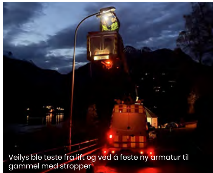
Test av armaturen «Skipper» som vurderes behagelig å se på, uten blinding og med god lysfordeling
