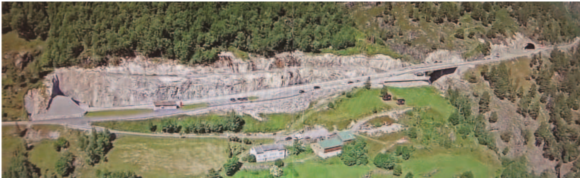
Veganlegg med rasteplass og utkikkspunkt på Ljøen. Gården Ljøbakken i front. Nye tunneler, ny bro og rasteplass med utkikkspunkt har gitt store sår i landskapet
