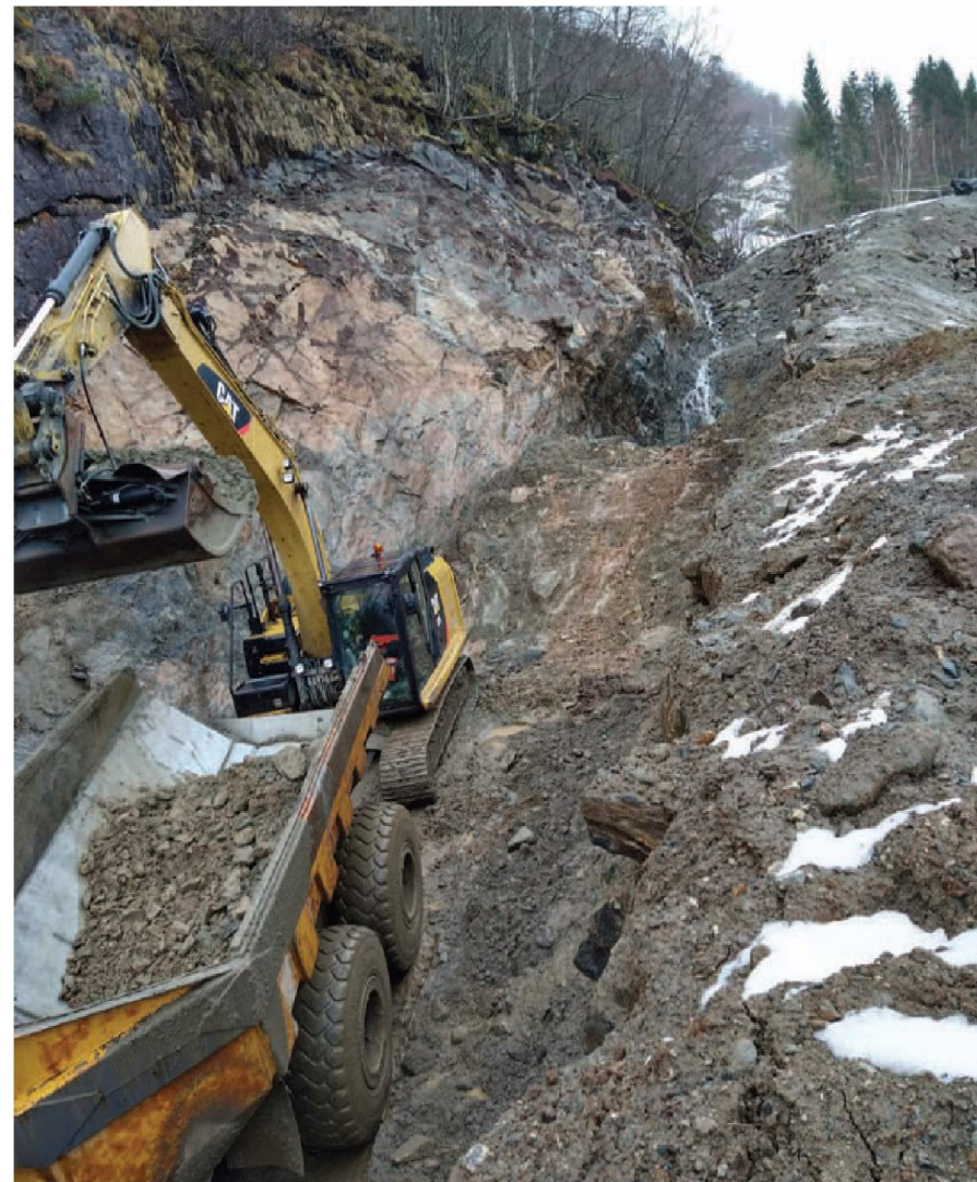
Etablering av rassikring og tilrettelegging av nytt bekkefar innenfor LNA_1.
