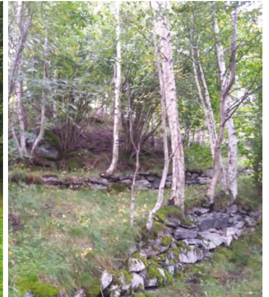
Gamle murer i fare for gjengroing og rotvelt
