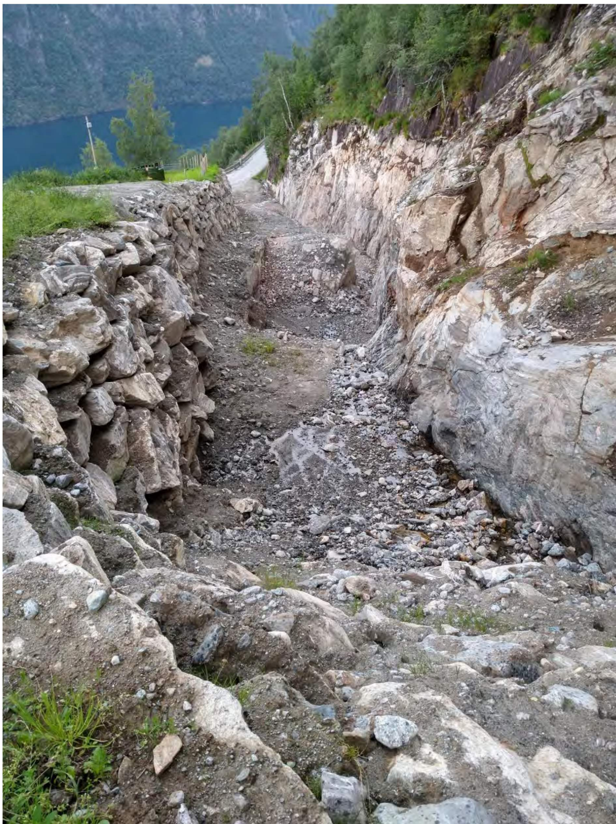
Figur 5 Rasvoll i øvre del. Utgravd bergoverflate og murer med høyde ca. 1-3 meter (22.12.2020)
