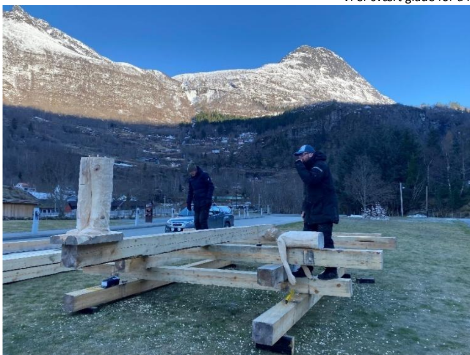
Frå monteringa av Simon Wågsholm sin installasjon ved Fjordsenteret.
