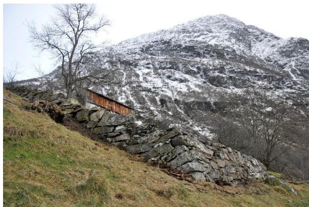
Store terrengmurar ved Møllstunet vart sett i stand på seinhausten.
