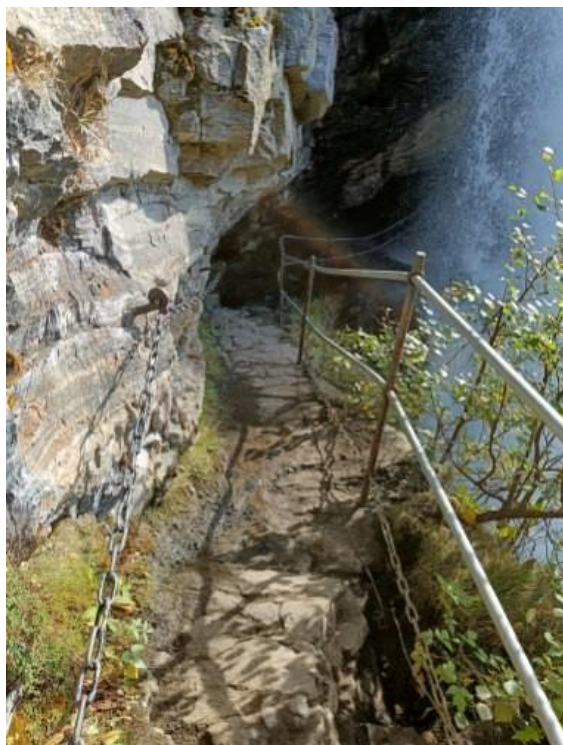
Det er gjort utbetringsarbeid på gjerdet ned til fossefallet Storsæterfossen.
