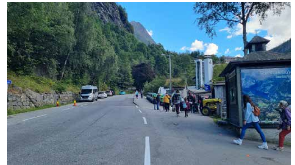
MANGLENDE FORTAU – UTFLYTENDE VEIAREAL
