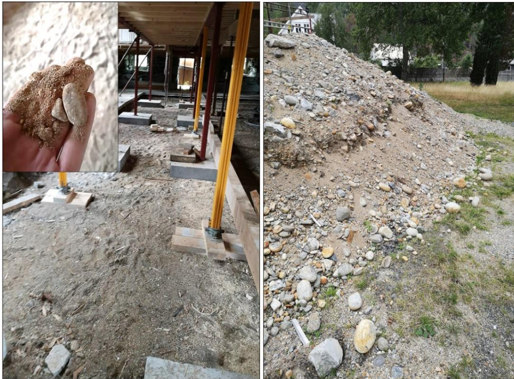
Figur 8. Observerte løsmasser under grand hotel (t.v.) og i en haug med oppgravde masser øst for Grand Hotel (t.h.).
