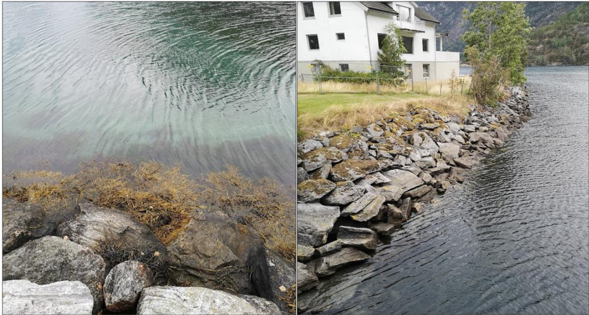
Figur 10. T.v.: Erosjonssikret strandlinje og sandbunn, sett fra moloen på tiltaksområdet mot fjorden i øst. T.h.: Steinsatt elvebank, sett mot nordøst fra Hellesylt bro.
