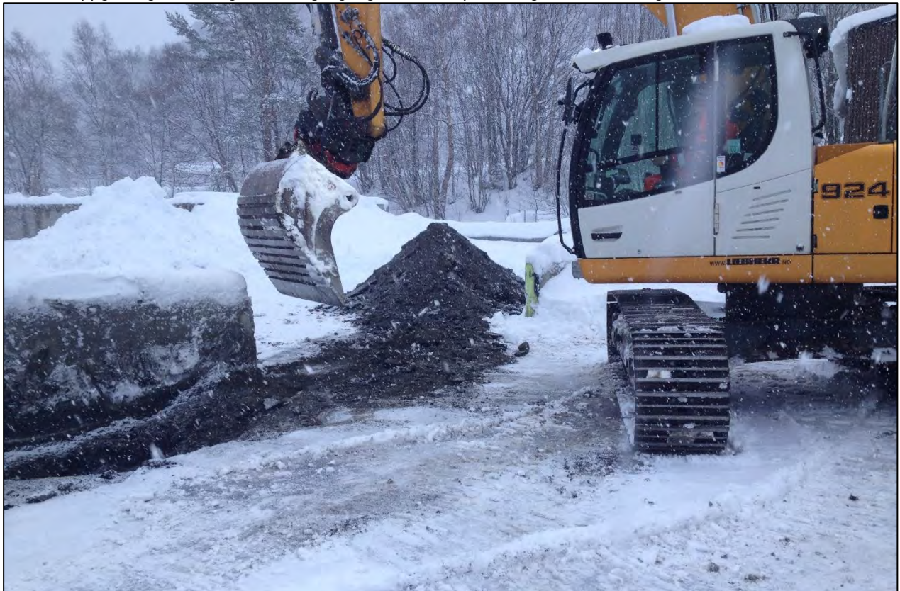
Bilder 2; Oppgraving ved P4 og midlertidig lagring av masser på betongdekke i sorteringshall.
