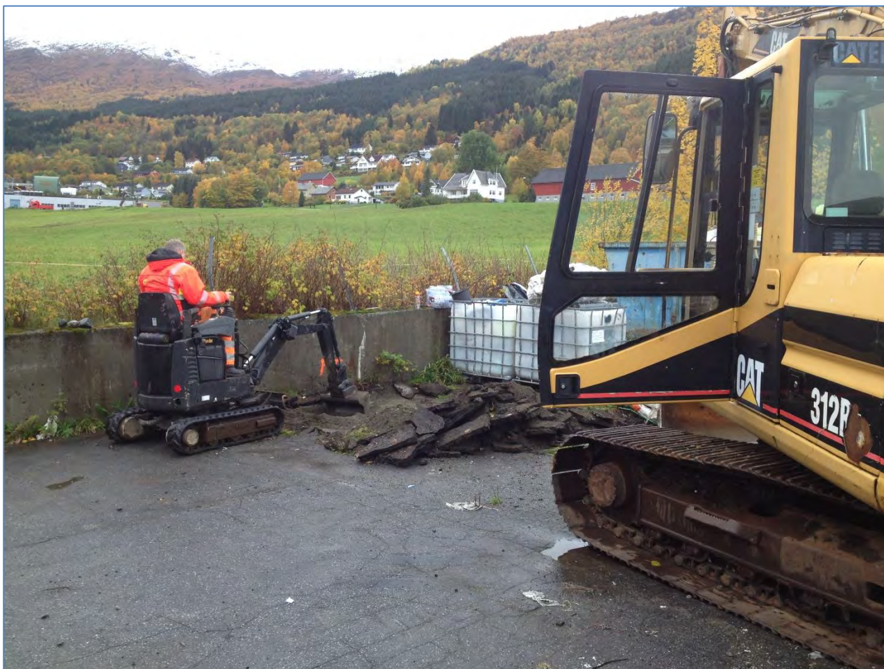
Bilde 1: Oversiktsbilde graving for prøvetaking med stor og liten maskin
