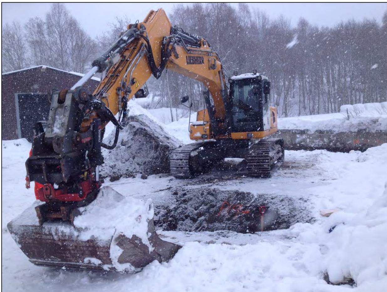
Bilde 1: P19 fjerning av masser og prøvetaking
