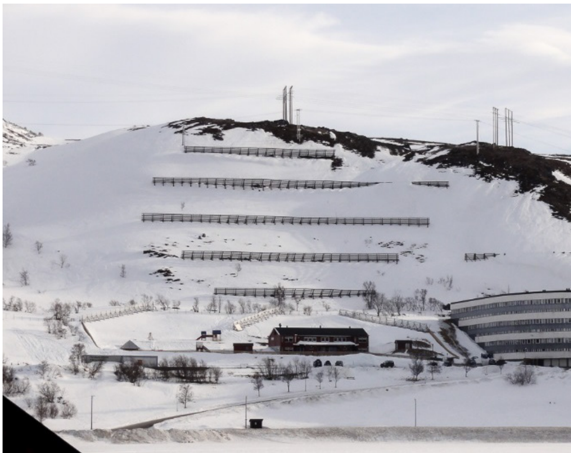
Figur 5 Eksempel på støtteforbygningar frå Hammerfest.
