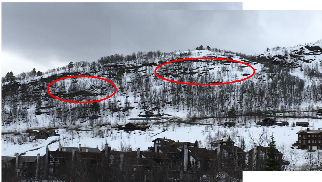
Figur 4 Oversiktsbilde av Skarhaugen med relativt lite snø i terrenget. Områder som skal sikrast med støtteforbygninger er omtrentleg markert med raudt omriss.
