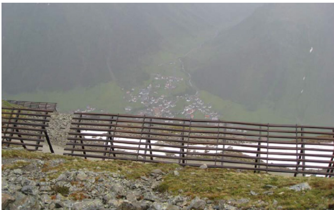
Figur 6 Eksempel på støtteforbygningar av stål (Galtür, Østerrike).
