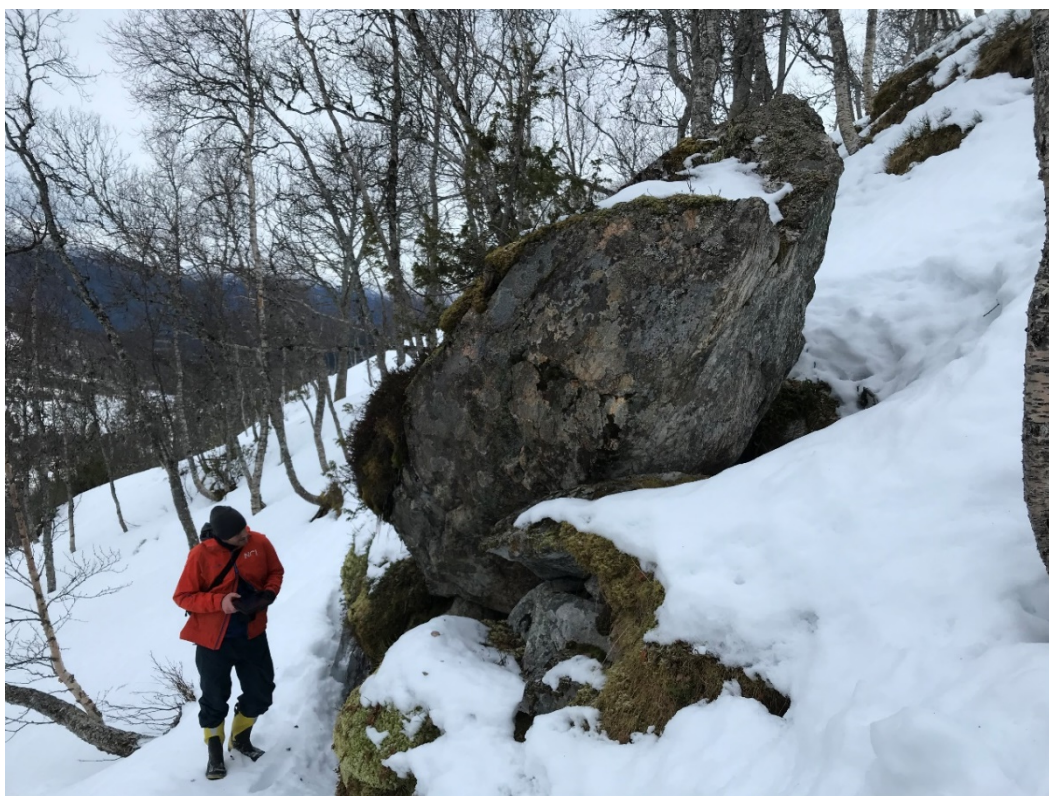
Figur 11 Avløyst blokk som truleg bør fjernast/sikrast
