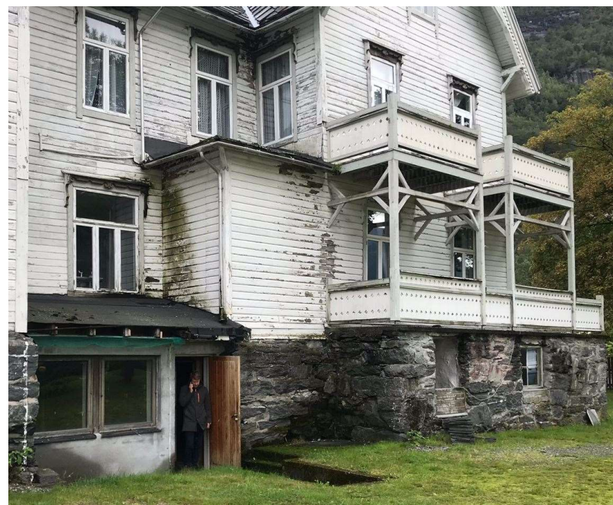
Tilstand før renovering
