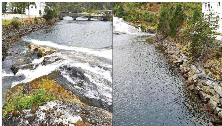
Figur 9. Hellesyltfossens utløp i fjorden med steinsatt elvebank uten fare for erosjonsinduserte brudd. T.v.: Sett fra fossen. T.h.: Sett vestover fra Hellesylt bro.
