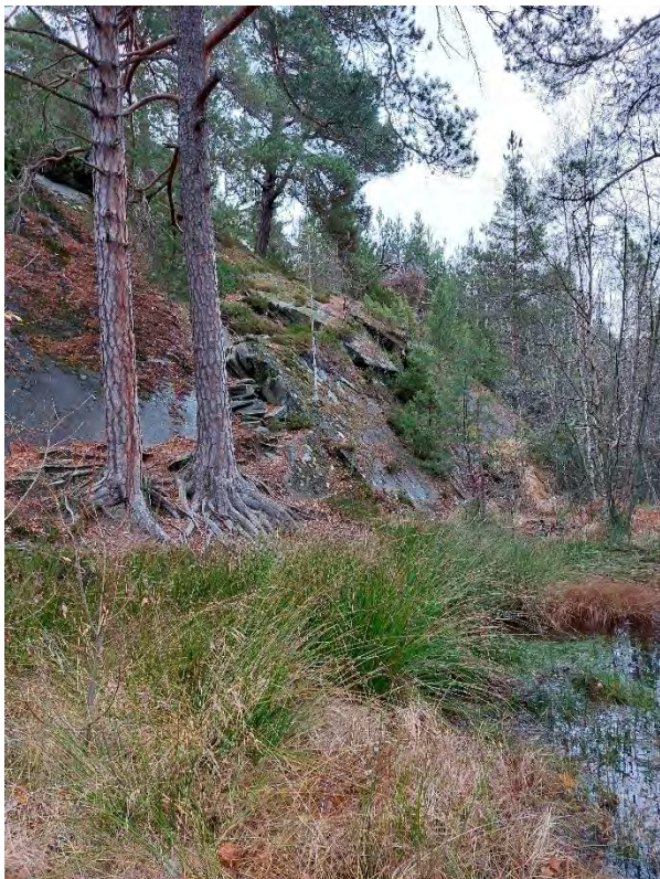
Figur 16: Omtalt bergvegg under Solvegen. Åpne sprekker parallelt med bergveggen fører til nedfall av små bergflak. Til høyre i bildet vannmettet jord i lavning nord for prosjektet med utløp mot øst til fjorden. Det ble observert enkelte mindre steinplatter som var løsnet og gliet ned til skråningens foten.
