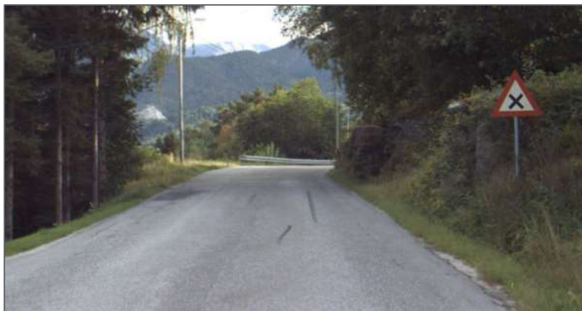
Figur 9 Fareskilt 124 Farleg vegkryss, plassert nesten 200 meter nord for kryss med Kjølåsvegen (Vegbilder.atlas.vegvesen.no, aug. 2021)
