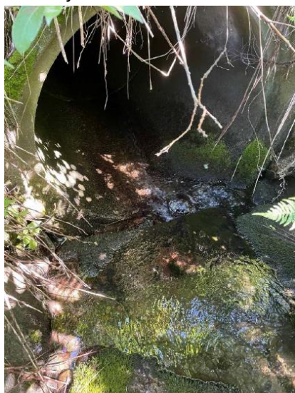
BILDE 3: EKSISTERENDE INNLØP PÅ DN1200 KULVERT
