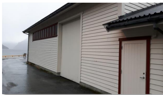
Figur 15: Kaihuset ved noverande ferjeleie i Hellesylt sentrum.
